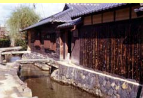
武家屋敷に沿った藍場川
