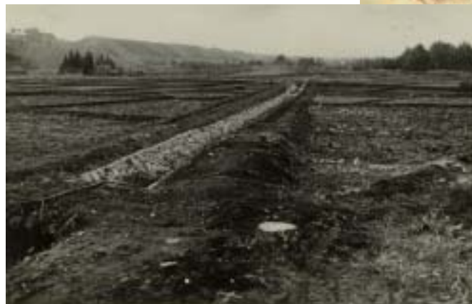
疏水の開通により安積原野は大水田地帯に生まれ変わった
