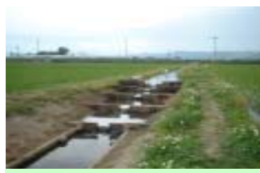
生態系に配慮した排水路
